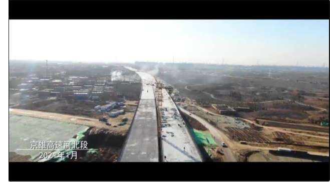
京雄高速道路河北区間主道路工事 完了
