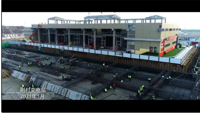
劇村変電所屋根工事終了
