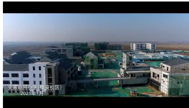
史家胡同小学(雄安支校) 建設中
